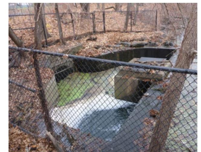
Aliviadero de toma y desagüe del Van Cortlandt Lake, donde se canaliza el agua hacia el sistema de alcantarillado combinado.
