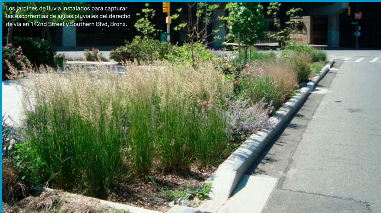
Los jardines de lluvia instalados para capturar las escorrentías de aguas pluviales del derecho de vía en 142nd Street y Southern Blvd, Bronx.
